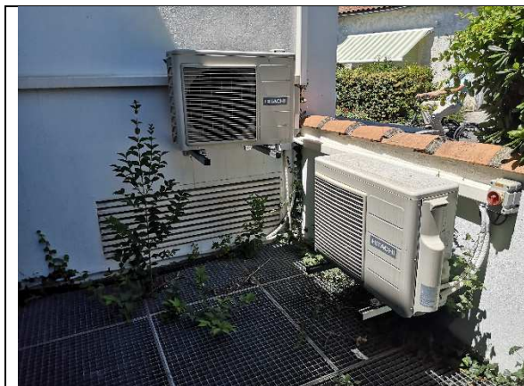
Marque HITACHI type RAC-60WPA x 2 Fonctionnant au R410a Puissance froide unitaire = 6,1 kW
