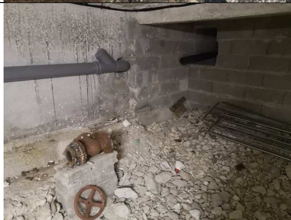
Ancienne AEP (abandonnée) dans le vide sanitaire du bâtiment A
